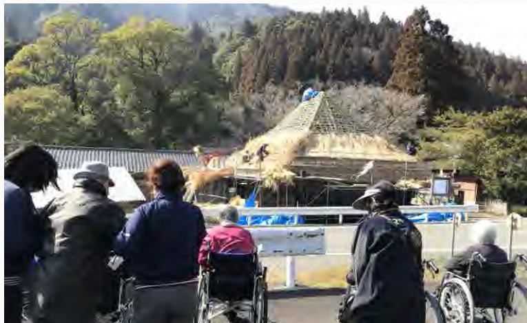
屋根葺き替え中の「宮野々廻り舞台」を見学
